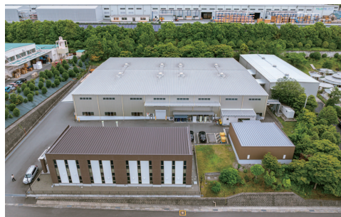
プラスチック製造メーカー開発棟
