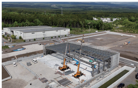
物流施設建設工事
